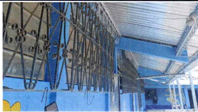
Foto 2: Estructura de soporte tipo joists con mantenimiento
