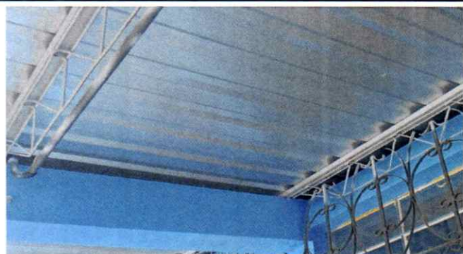
Foto 1: Cubierta de lámina concluida
