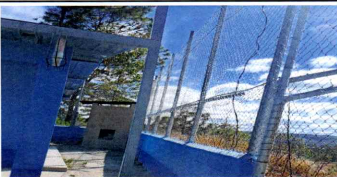
Foto 5: Malla y tubo HG de muro perimetral reparados
