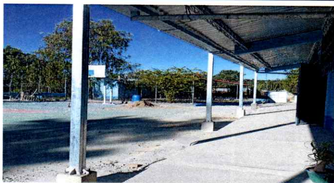
Foto1: Estructura de metal galvanizada instalada
